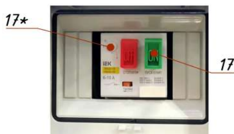
Рисунок 64. Автомат защиты и запуска двигателя.
