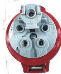
Рисунок 2. Вид розетки со стороны контактов.
